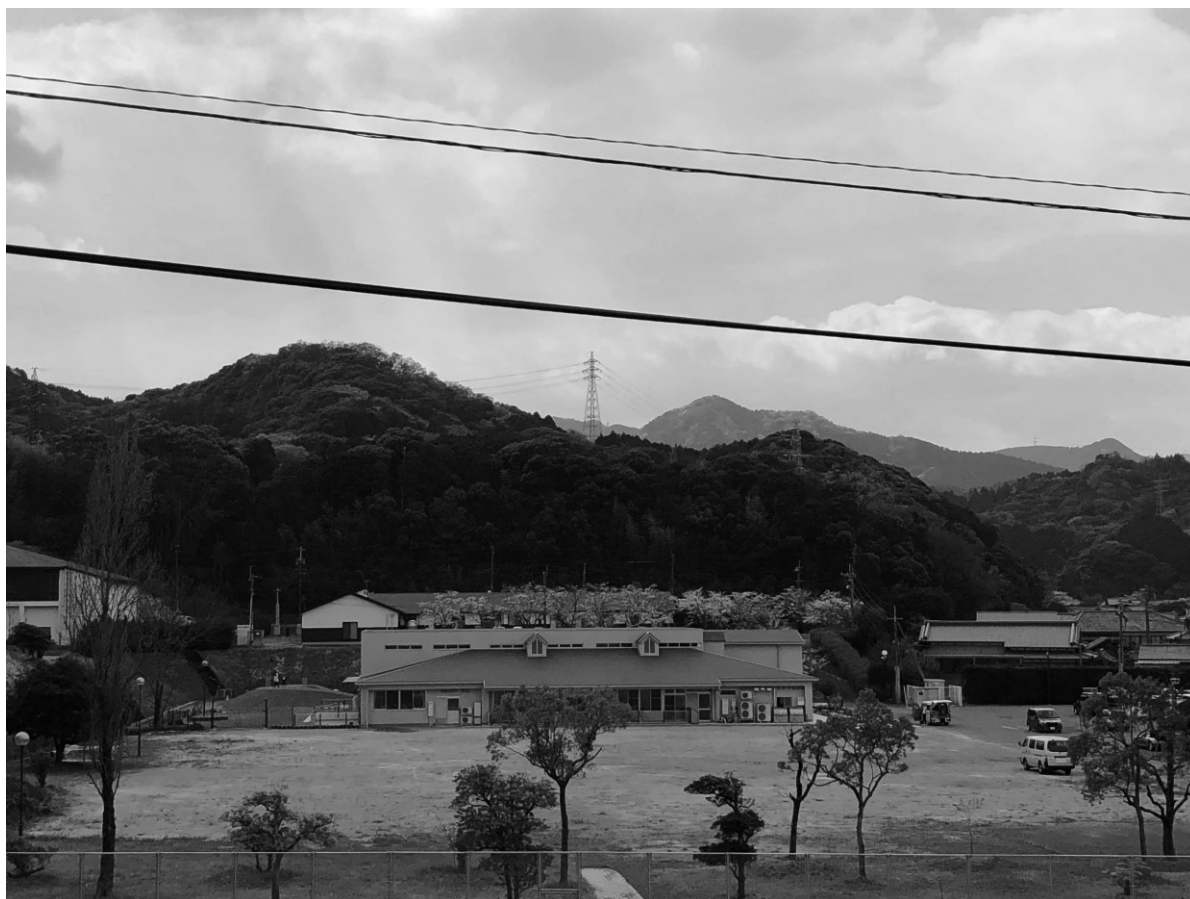
北側から見た園舎です。手前に残された土地にも子育て支援施設を建設する予定です。
