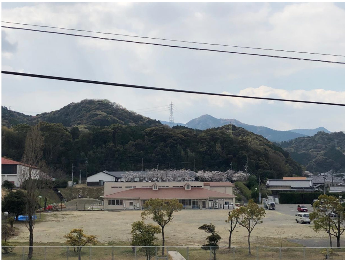
北側から見た園舎です。手前に残された土地にも子育て支援施設を建設する予定です。
