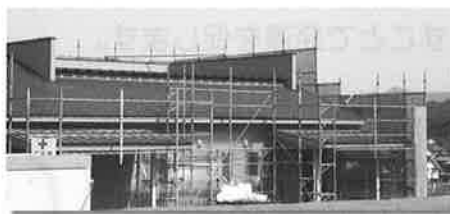
建設中の建物
